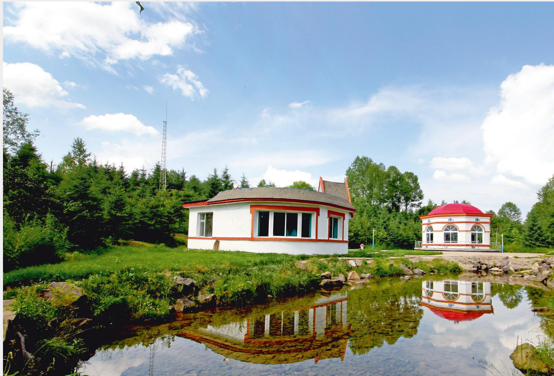
■ 图3.20 吉林省抚松县某泉眼及泵站
